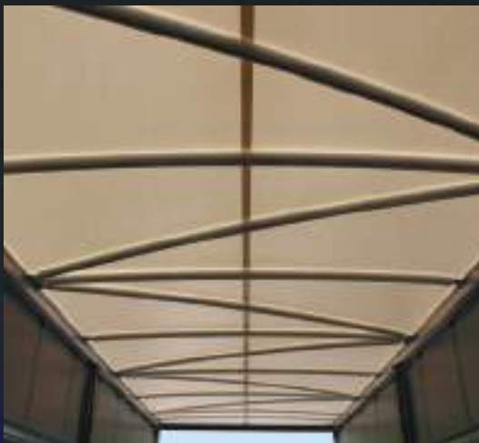
Teto treliçado com revestimento de espuma entre lona e varão.
